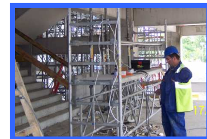
Stadion w Poznaniu – prace elektryczne
