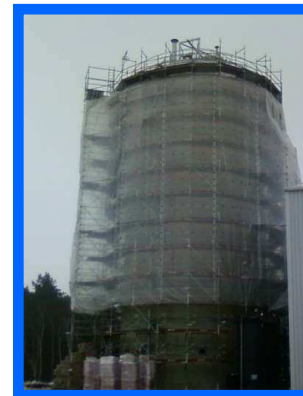
Zakład zagospodarowania odpadów w Trzebani
