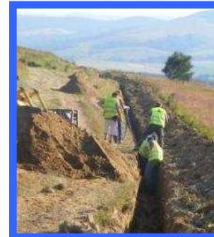
FW Bukowsko – prace ziemne przy przyłączach elektrycznych
