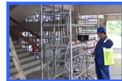
Stadion w Poznaniu – prace elektryczne
