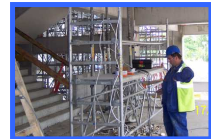
Stadion w Poznaniu – prace elektryczne
